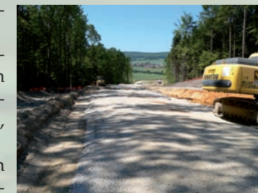
Neubau einer Bundesstraße
